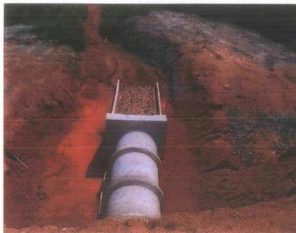
Foto 11 – Bueiro BSTC Ø 1,20m, boca e dissipador de energia est.373+11 PD
